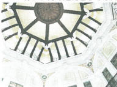
南北ドーム内側の天井
